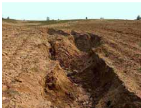
Figura 18. Erosione per burroni sviluppatasi nelle zone di accumulo dei materiali terrosi nel medesimo terreno preparato per l'impianto del vigneto.
